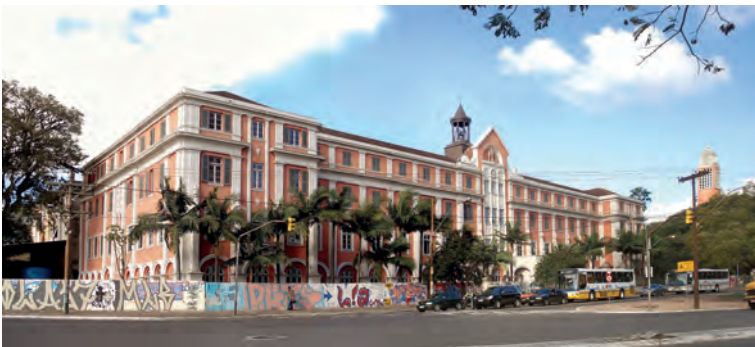
Prédio atual, inaugurado em 1930.
